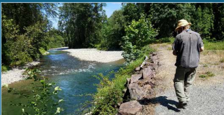
Inspección del dique en curso
