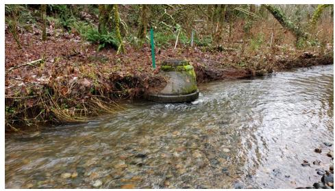
WTD 的 Coal Creek 下水道升级工程将为日益发展的地区提供废水处理能力,此工程同时给我们提供机会将大部分在用的管道移出 Coal Creek。这项临时河岸稳固工程将协助我保护好该管道及珍贵的溪流,直到我们将该结构移除,这是 Coal Creek 下水道升级工程的一部分。
