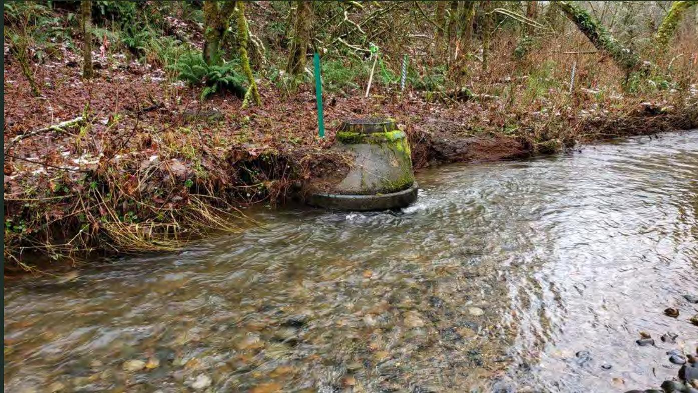
Las inundaciones en diciembre del 2019 erosionaron la orilla de un pozo de mantenimiento cerca del Upper West Trailhead.
