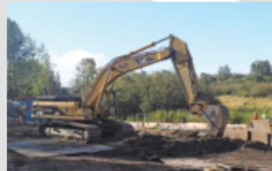
1. 承包商用挖明溝的方式連接新的 Coal Creek管道至 East Side Interceptor截留管，然後排入 South Treatment Plant，隨後修復地面植被。
