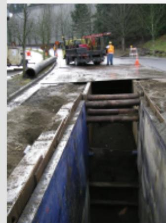
7. 在 Coal Creek Parkway 上通過挖明溝的方式，承包商恢復新管道和 Bellevue 市管道的連接。“許可證條件”中將會說明在這一繁忙道路上的交通影響。
