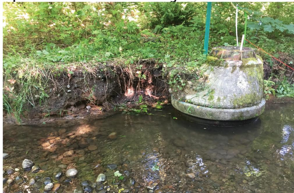
Las inundaciones de diciembre de 2019 erosionaron el banco alrededor de este agujero de mantenimiento (izquierda). Un proyecto de reparación temporal (derecha) ayudará a proteger la estructura hasta que el proyecto se complete en 2027.
