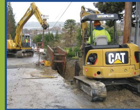
सड़क के नीचे सीवर पाइप स्थापित करने से पहले खुदाई करने वाले King County के कर्मचारियों का उदाहरण
