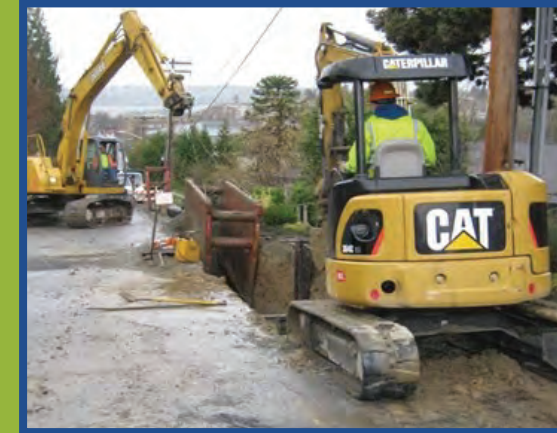
Un ejemplo de los equipos del condado de King excavando antes de instalar una tubería de alcantarillado bajo una carretera.
