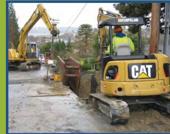
King County 工作人員在道路下方安裝下水道前進行挖掘的範例。
