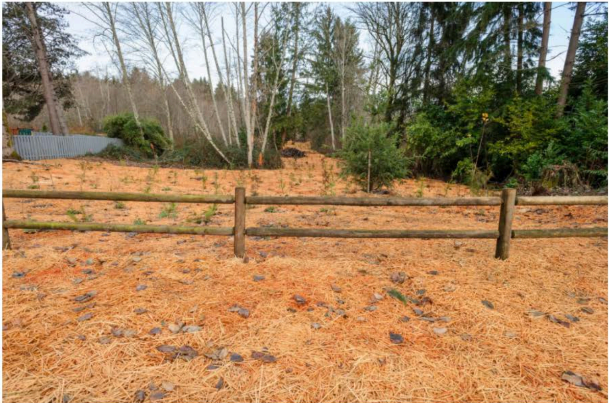
施工后的示例现场
