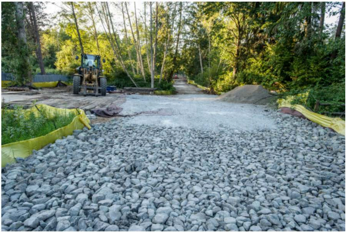
施工期间的示例现场
