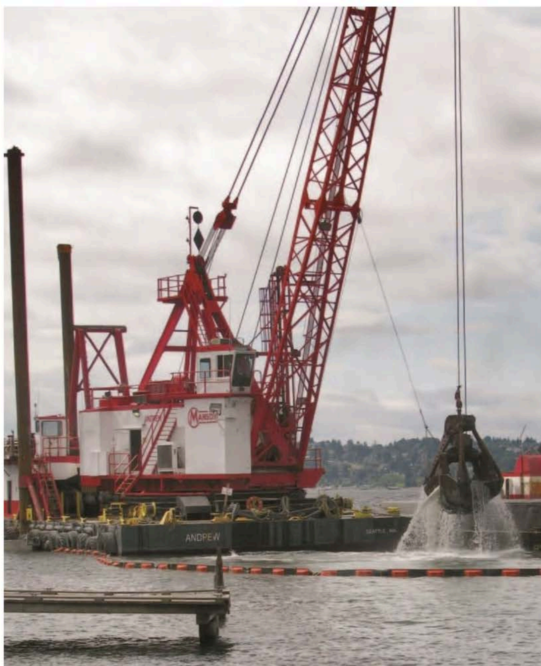
Excavadora de doble cara
