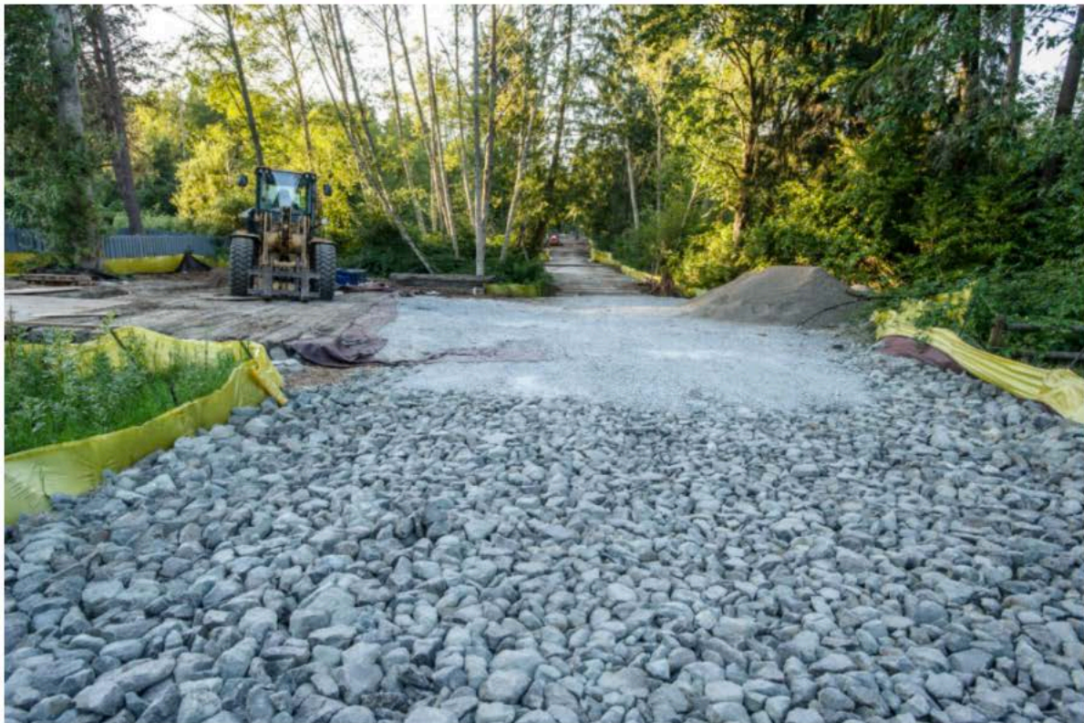
Sitio de ejemplo durante la construcción
