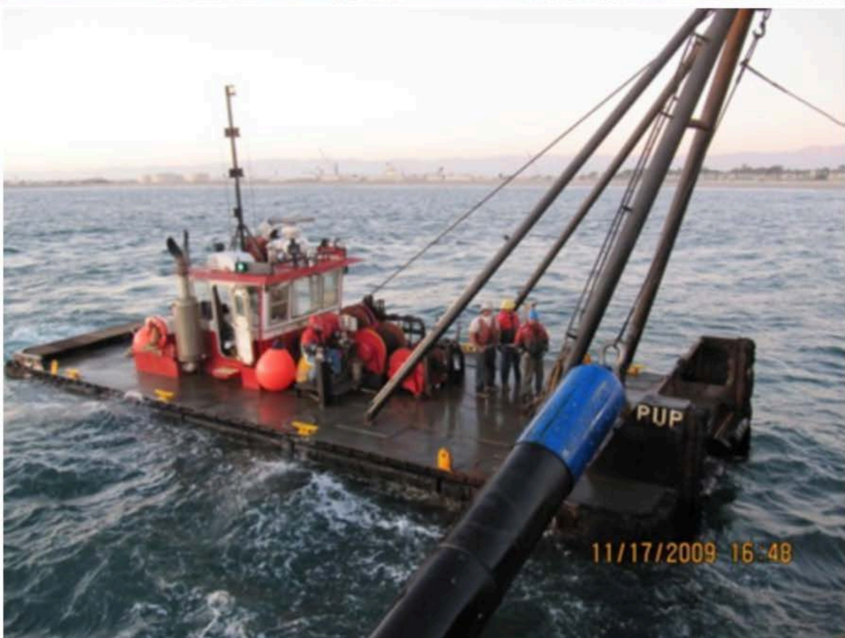
大部分的修繕工作將位於水中的駁船處。駁船將依工作進度而移動。
