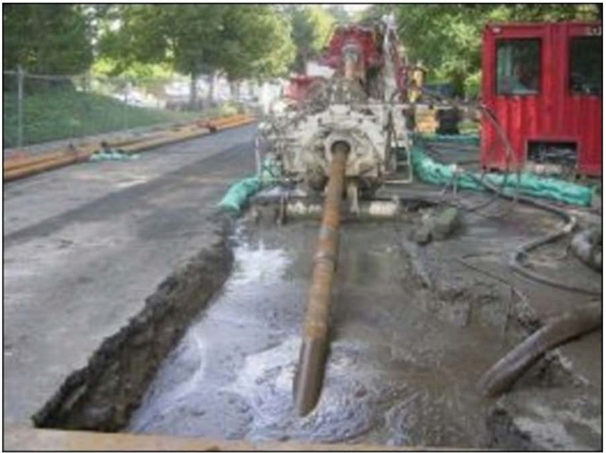
施工人員在使用擴孔機（如上圖所示）擴大井孔的同時將使用一種泥漿來幫助井孔保持打開狀態。
