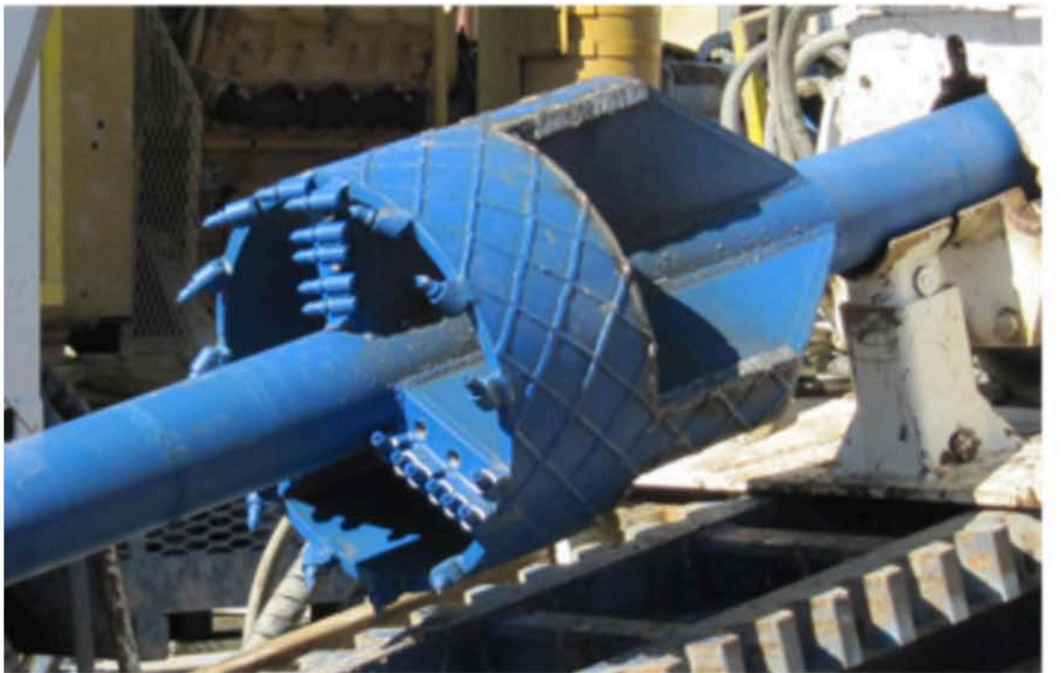
施工人員通過用設備鑽出足夠大的井孔並將管道穿過來安裝新管道。地表上會有一根電線實時追蹤地下鑽井設備的位置。
