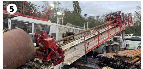
照片: 1: 在将管道拉入Enatai山坡地下之前, 3,000英尺熔接管道漂浮在Lake Washington上 2: 一台起重机将新的下水管道从水中吊起, 准备地下铺设。 3: 将管道送入Enatai Beach Park旁边的HDD孔。 4: 一台位于Sweyolocken的钻机拉动管道末端穿过管道通道。 5: 新的下水管道进入位于Enatai Beach Park的管道通道。
