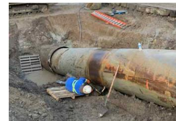
正在Sweyolocken准备场地, 以便拉出HDD管道。
