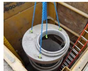
工作人员将在两条管道连接处安装一个维护孔。
