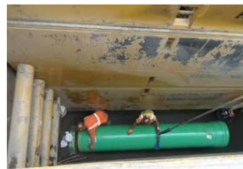
支撑能够挡住土壤, 使工作人员可在地下安全施工。
