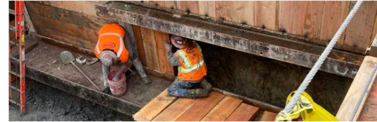
工作人员将建造挡土墙并安装木护墙板(称为挡土板), 以在建造临时泵站之前挡住土壤。
