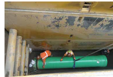
El apuntalamiento retiene la vela para que las cuadrillas puedan trabajar con seguridad por debajo del nivel de la superficie.
