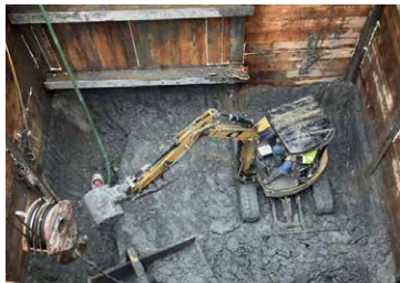
Las excavadoras preparan los cimientos para la estación de bombeo provisional.
