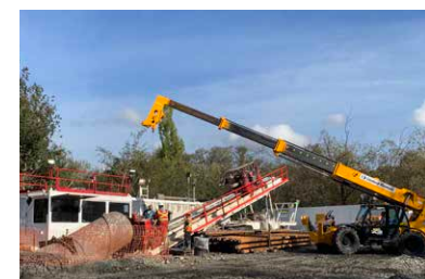
El personal de las cuadrillas instala una placa de brida, que permite atornillar fácilmente los segmentos de tubería.
