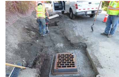
Las cuadrillas instalan mejoras de drenaje en 90th PI SE.
