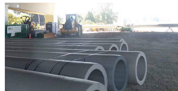
Áreas de preparación cerca de las zonas de construcción.
