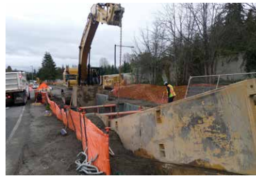
Los cajones de zanja permiten a las cuadrillas trabajar con seguridad bajo tierra.
