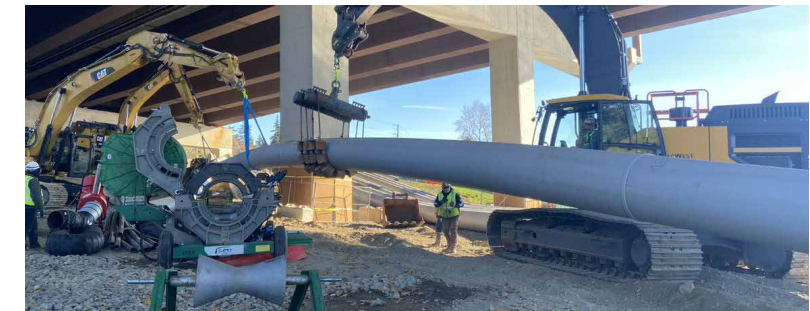
Conexión de la tubería al registro de HDD por el Enatai Beach Park.
