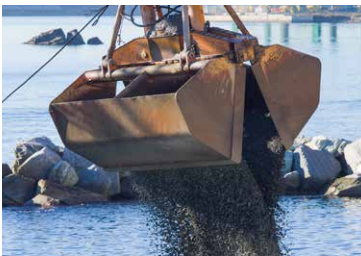
El dragado es el primer paso para la instalación de tuberías en cuerpos de agua.
