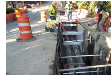
Este año las cuadrillas terminaron de instalar una nueva tubería principal de alcantarillado en SE 22nd St.
