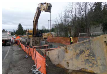
支柱箱可讓工作人員安全地在地面下方工作。
