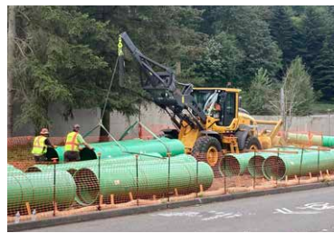
在Mercer Island上的I-90路線附近安裝32吋管路。
