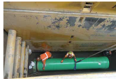
支柱可擋住土壤，以便工作人員安全地在地面下方工作。
