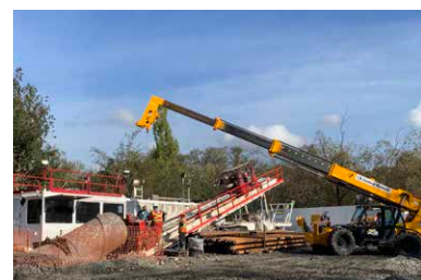
工作人員將安裝一個法蘭板，以便輕鬆地將各段管路固定在一起。
