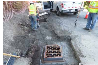
工作人員將在90th PI SE安裝下水道改善設施。
