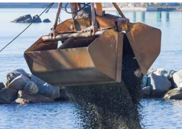
挖泥是水下管路安裝的第一個步驟。
