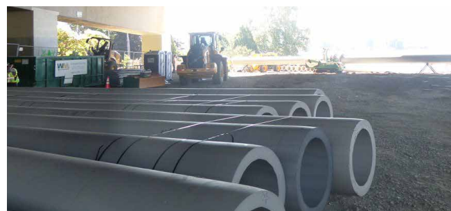
施工三角錐周邊的暫存區。
