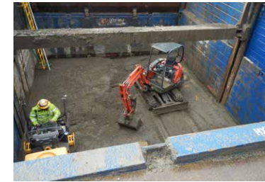
SE 35th PI的異味控制設施將消除兩條管路接合處的異味。
