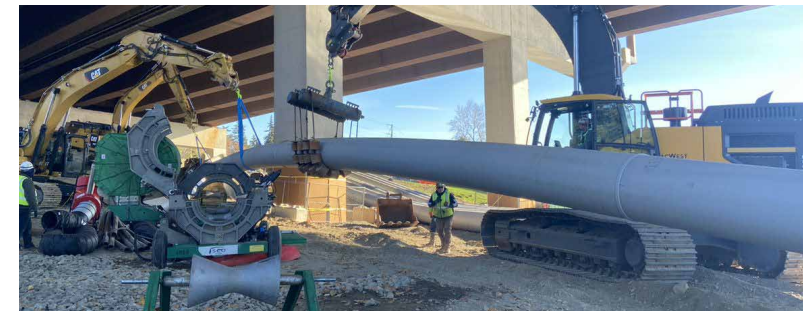
將管路接入至Enatai Beach Park的HDD孔洞。
