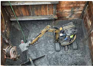
挖掘人員將針對臨時抽水站挖掘地基。
