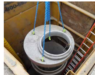
工作人員將在兩條管路連接處安裝維修孔。
