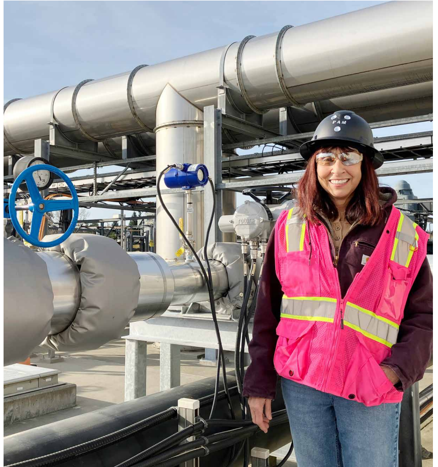
La operadora principal Pam Restovic está parada junto al equipo de la planta de tratamiento de Brightwater.
