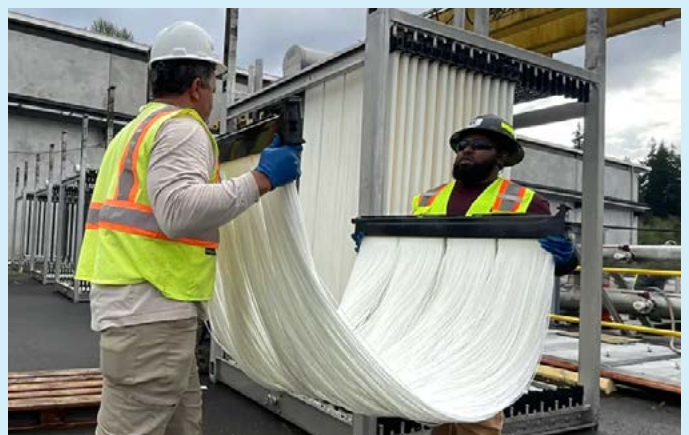
Un trabajador de servicios públicos del condado de King y un contratista trabajan juntos para instalar nuevos filtros de membrana..
