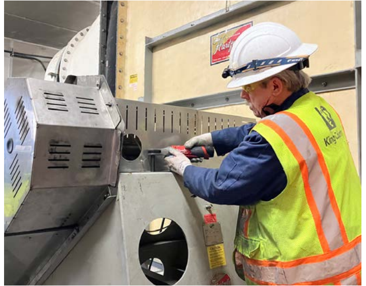
Un mecánico del condado de King mantiene el equipo de control de olores en Brightwater.
