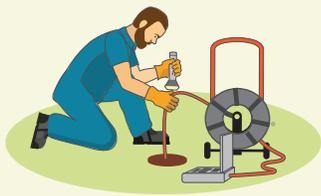
请水管工或承包商检查您的侧向下水道，他们会将摄影机伸入管道内。在需要时，对管道进行维修。购置房屋前请先完成这项检查。
